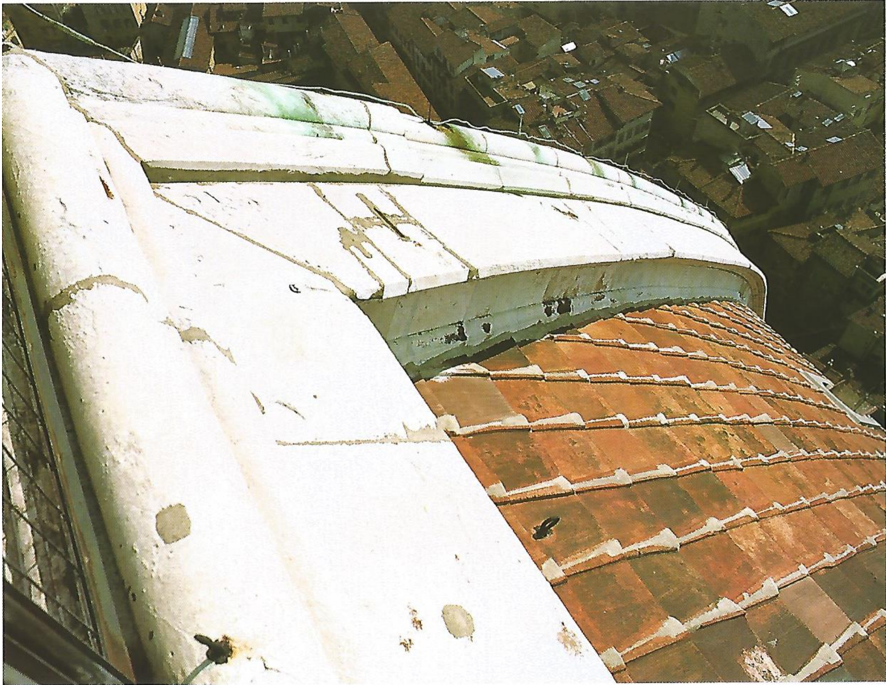
Détail d'une nervure de marbre, vue de la lanterne
